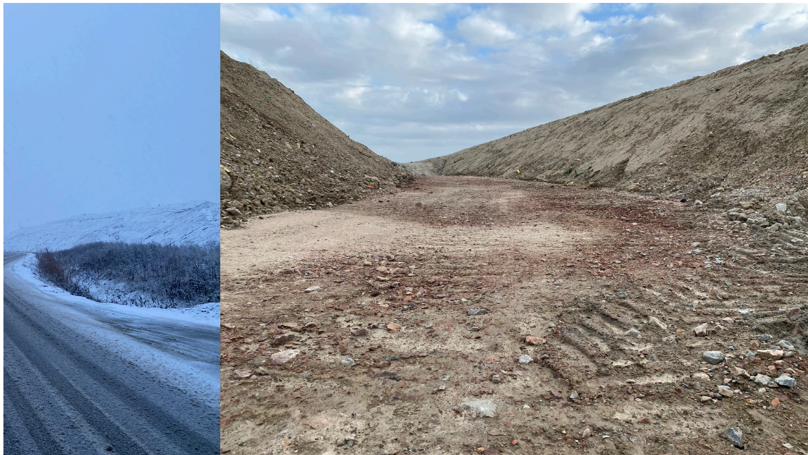
Massorna som grävts upp, som är avfall och klassas som byggmaterial och ska användas till att återställa området, Åkarp, 2021
